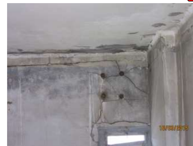
סדקים בחדר המדרגות שנגרמו כתוצאה מחולצת ברגי חיבור התורן
