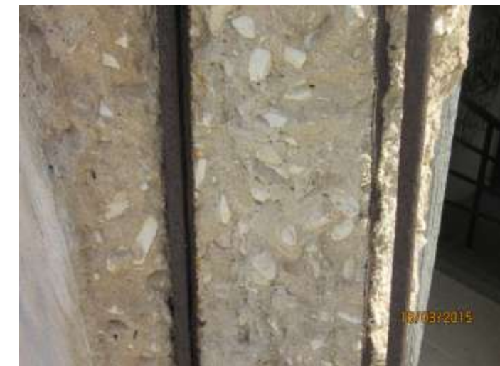
מבט על הרכב הבטון והברזל עשימש ליציקות
