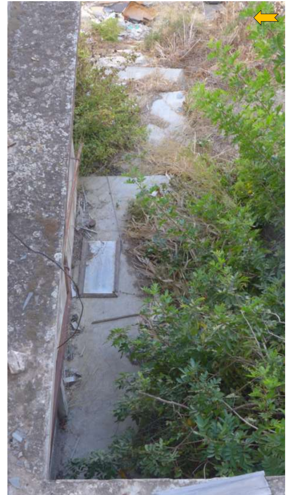
שביל הכניסה המקורי היה כנראה בנוי ממשטחי בטון. ניתן לראות שרידים סמוך לכניסה לבניין.
