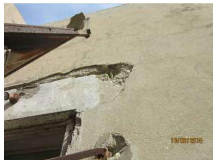
מבט מקרוב על הטיח שהתפורר בחזית הדרומית
